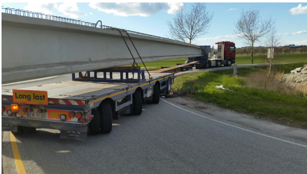
Figur 3.10. Transport og sikring av en prefabrikkert bjelke. Foto: Nordic Crane Sør AS.
