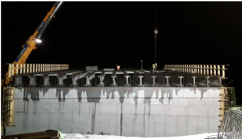
Figur 2.1. Prefabrikkert bro på strekningen E18 Tvedestrand – Arendal. Foto: Bjørn Hansen
