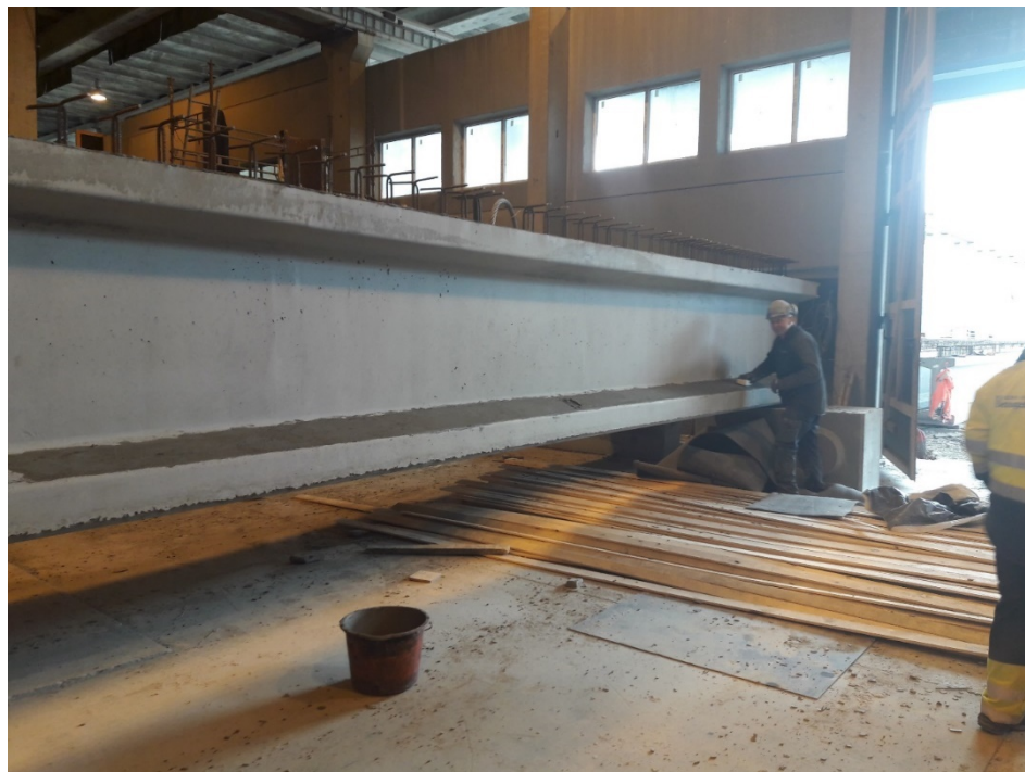
Figur 6.2. Prefabrikkerte bjelke. Foto: Henriette Foss
