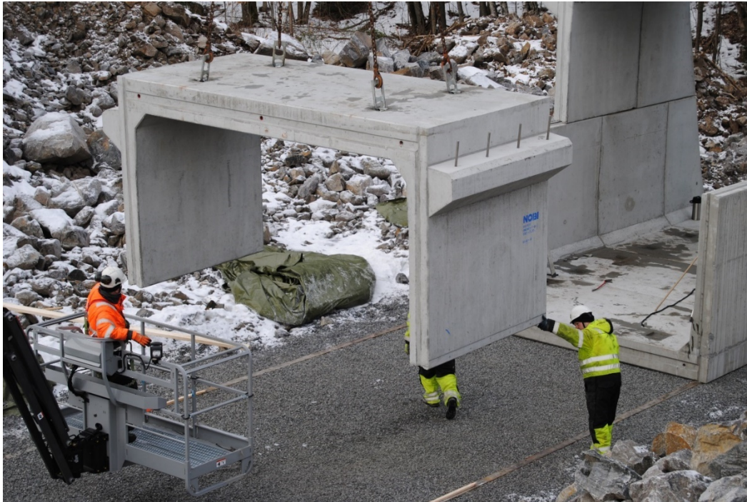
Figur 6.1. Montering av prefabrikkerte kulverter. Foto: Henriette Foss
